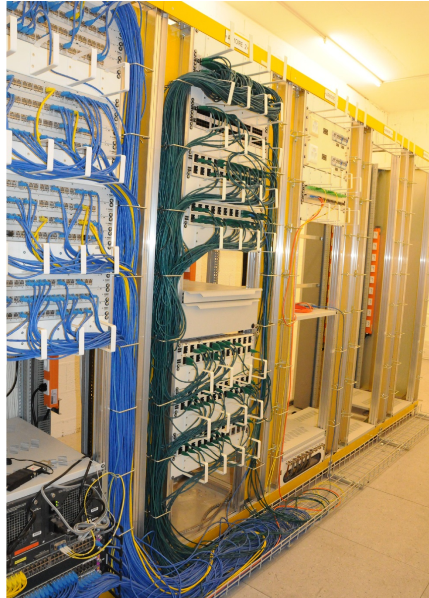
Armoires et canal à grille
