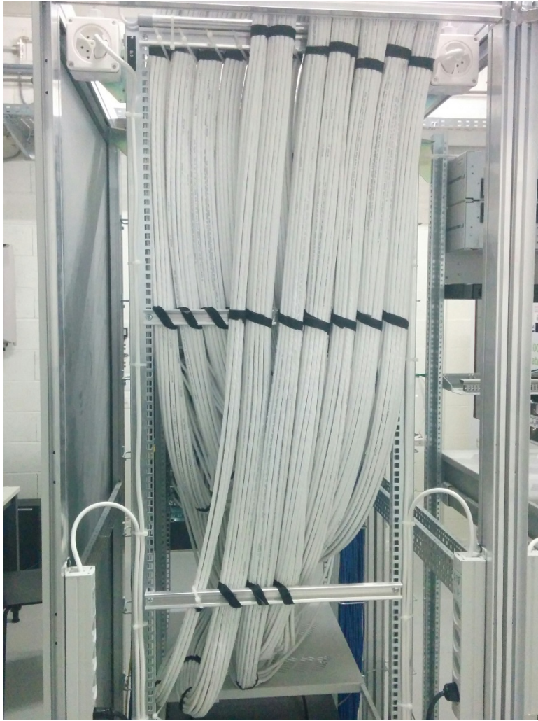
Exemple de rangement des câbles à l'arrière des armoires de brassage.
