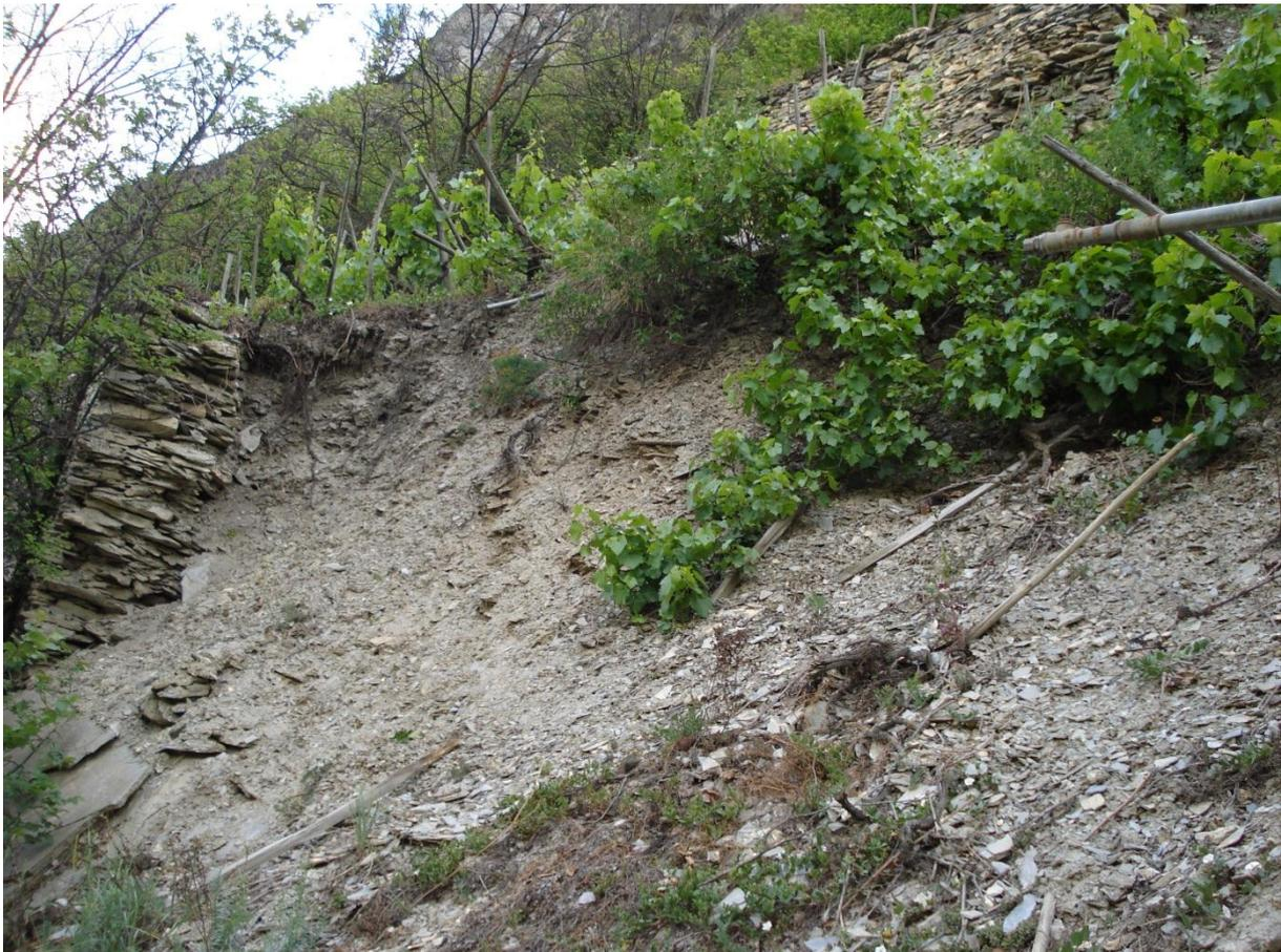
Rupture généralisée d'un mur en pierre sèche, Vallon de la Sionne, 2011
