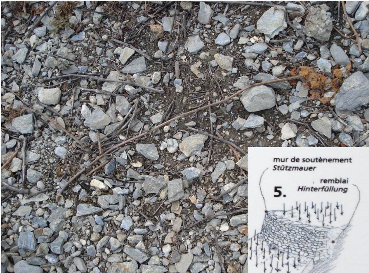
Détail de la composition du remblai à l'amont des murs en pierre sèche, Batassé, 2011
