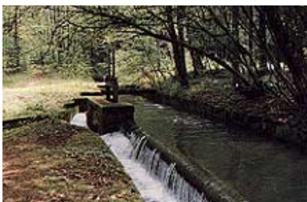
Illustration 2.6 – Dessableur combiné avec déversoir et vanne de vidange, à l'amont du canal de dérivation d'une petite centrale à Aigle (VD)
