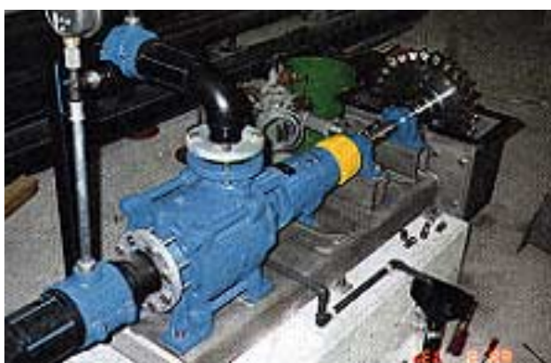
Illustration 2.9 b) – Turbine Pelton (8 kW) entraînant directement une pompe pour l'approvisionnement en eau potable de la commune de Brienzwiler
