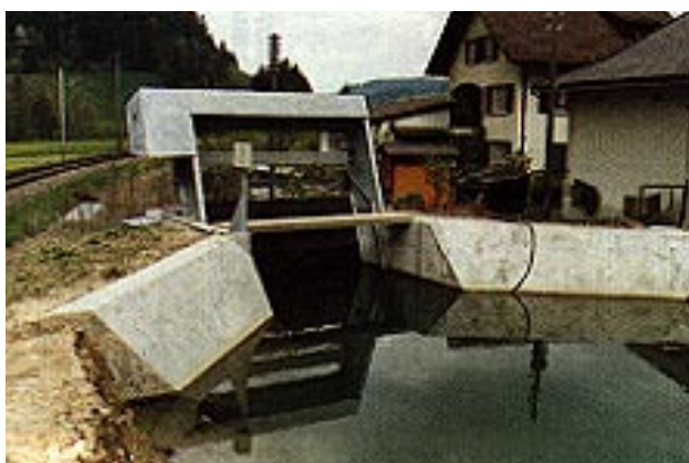
Illustration 4.3 – Dégrilleur automatique
