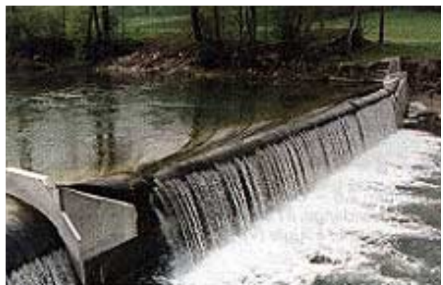
Illustration 2.4 – Exemple d'un barrage souple sur l'Ilfis à Bärau près de Langnau (BE)
