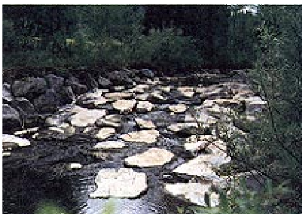
Illustration 3.4 – Rampe à ralentisseurs en blocs de rochers dans le Röttenbach, près d’Eggiwil
