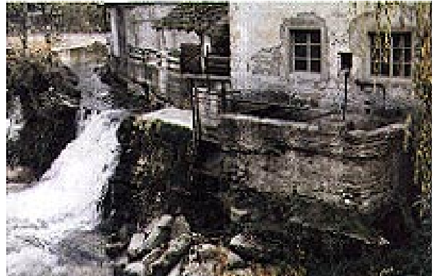
Illustration 4.1 a) – Vue générale de l'installation avant modernisation
