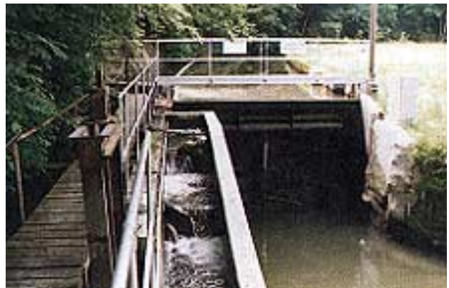
Illustration 2.3 – Exemple d'une prise d'eau latérale avec réglage de la retenue par un barrage à clapet. Cette petite centrale est située sur le Rothbach près de Huttwill (BE)
