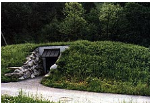
Illustration 3.8 – Petite centrale (250 kW) du Pont de la Tine (VD), totalement enterrée à l'exception de la porte d'entrée
