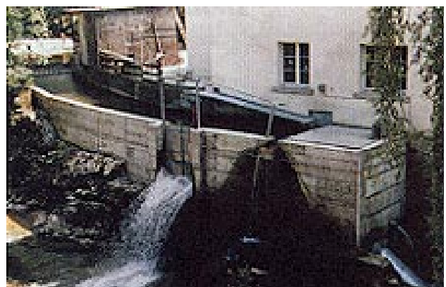
Illustration 4.1 b) – Vue générale de l'installation après modernisation
