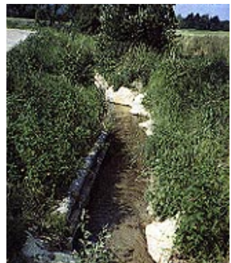
Illustration 3.3 – Correction d'un ruisseau du Mittelland bernois par des techniques naturelles; pendant la construction (en haut) et une année après
