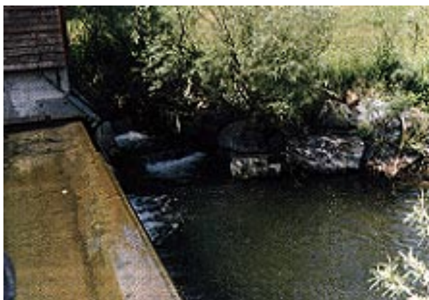
Illustration 3.6 – Entrée d’un ruisseau de détournement à l’aval d’un barrage à Kleindietwil (BE)
