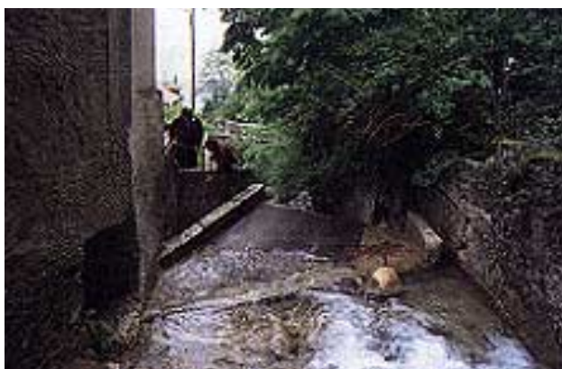
Illustration 2.5 – Exemple d'une prise d'eau tyrolienne à grille horizontale prélevant l'eau pour une petite centrale à Baulmes (VD)
