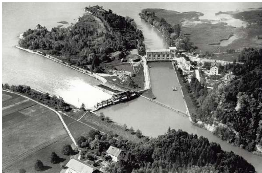
Figure 2 La centrale hydroélectrique de Hagneck aux alentours de 1920.
