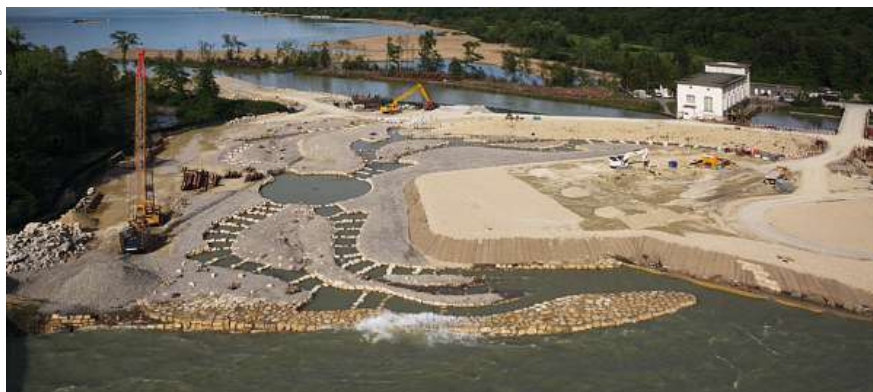
Figure 4 Une grande surface a été octroyée pour favoriser la mobilité des poissons. L'ancienne centrale se trouve à l'arrière-plan.
