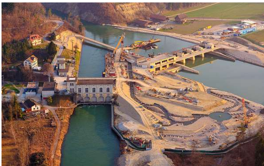
Figure 1 Construction de la nouvelle centrale hydroélectrique et de son impressionnant canal de dérivation pour les poissons (au premier plan).
