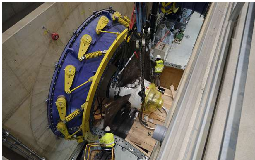
Figure 3 Mise en place d'une turbine bulbe Kaplan à axe horizontal.
