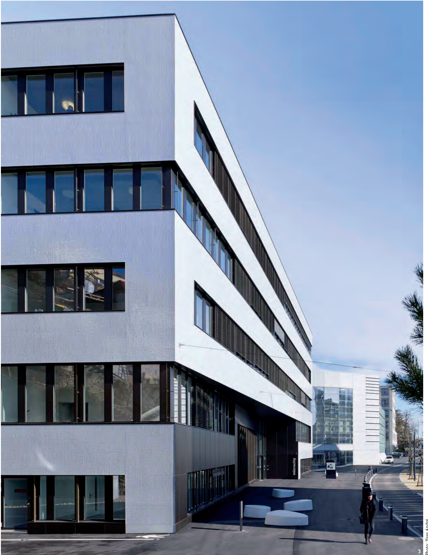
3 Détail de l'angle sud-ouest avec découpe signalant l'entrée depuis la rue de la Maladière
