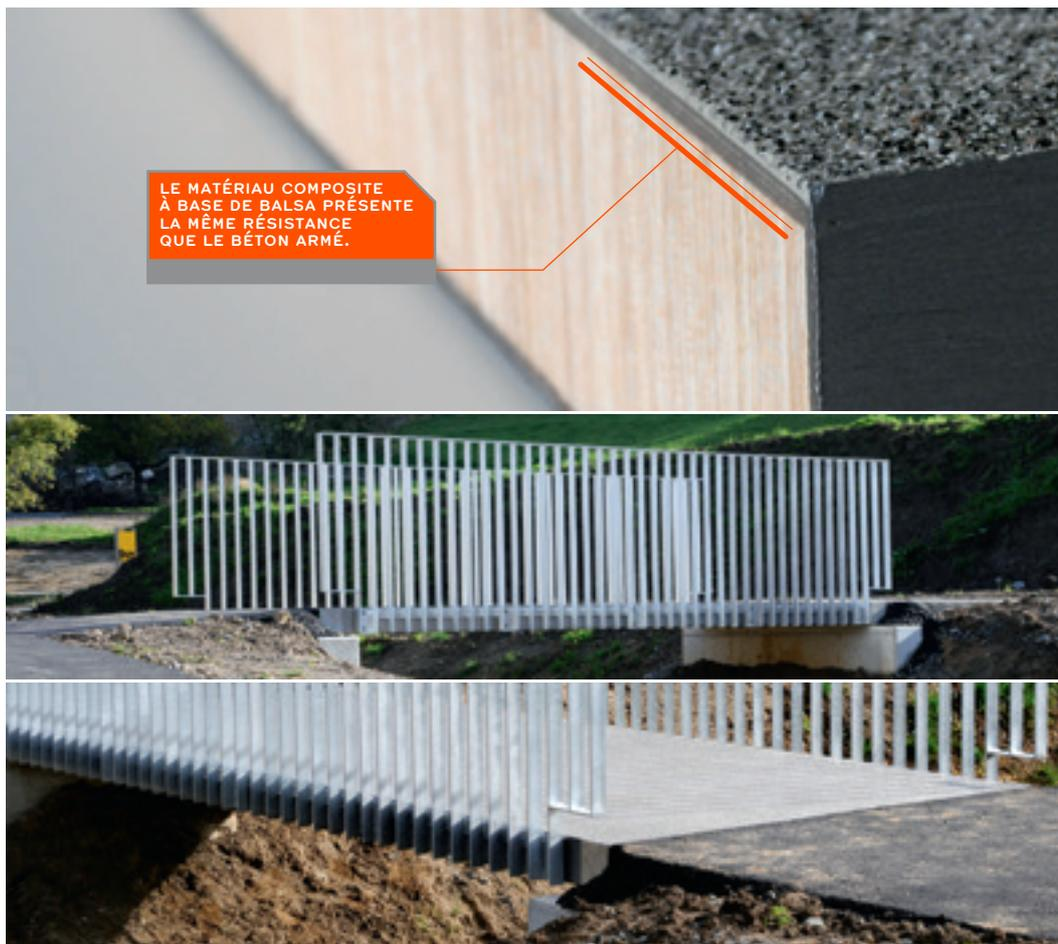
LE MATÉRIAU COMPOSITE À BASE DE Balsa PRÉSENTE LA MÊME RÉSISTANCE QUE LE BÉTON ARMÉ.
