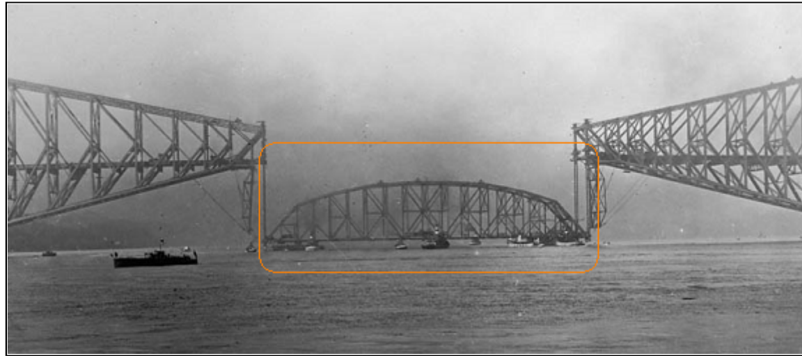
Figure 3: Montage de la partie centrale
