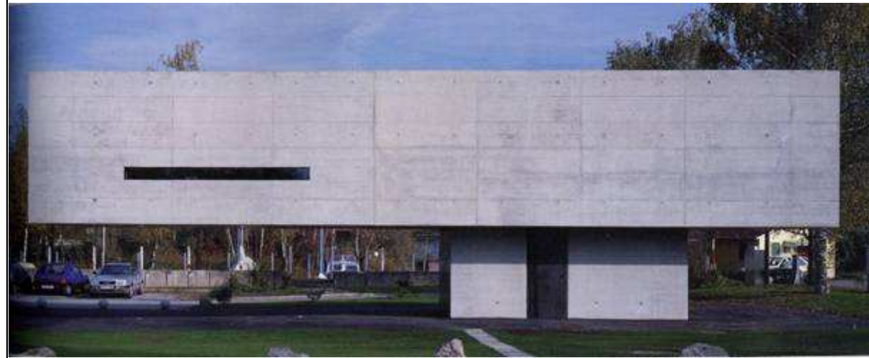
Figure 13: Vue latérale de la paroi à analyser
