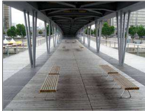
Figure 19: Vue de l'intérieur de la passerelle
