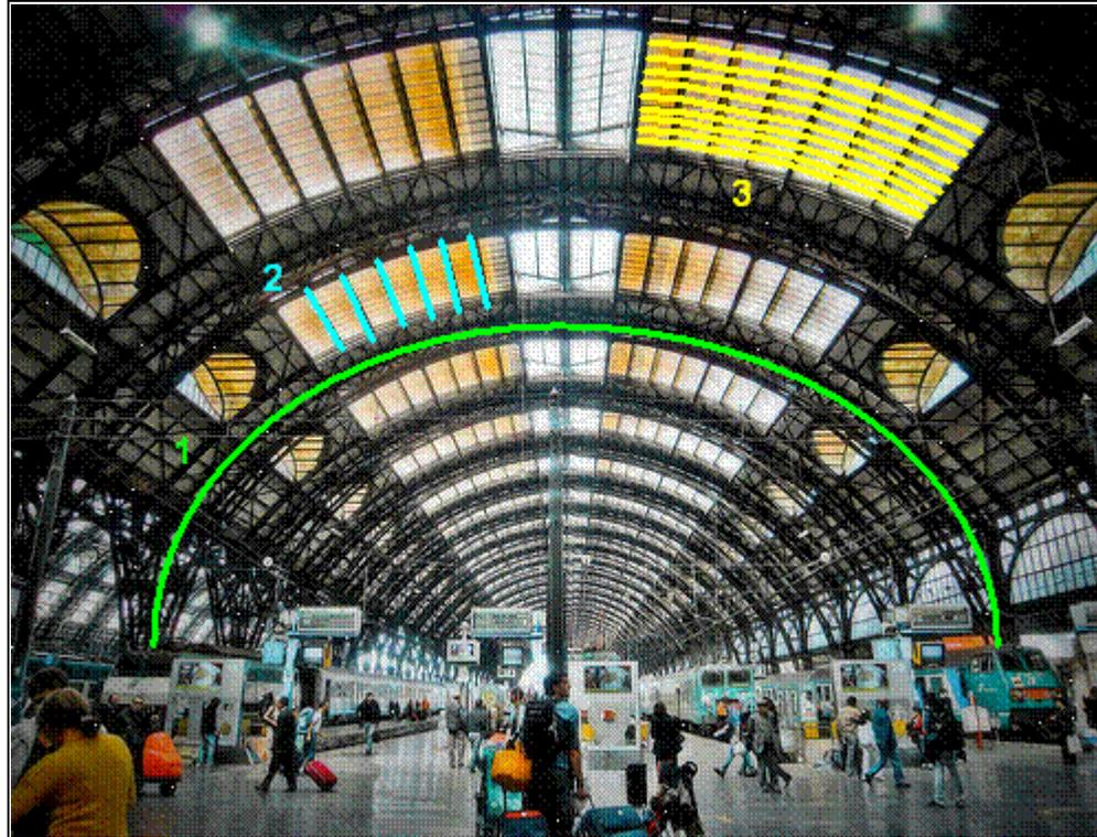
Figure 25: Structure porteuse de la gare de Milan
