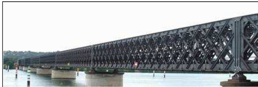
Figure 4: Viaduc d'Avignon France source, Structurae, photo Jacques Mossot
