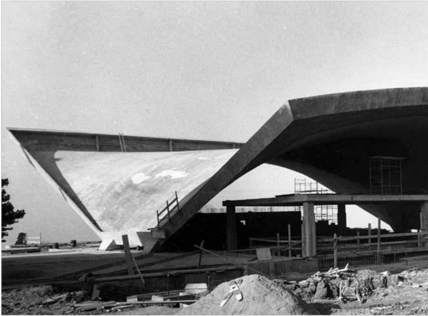
Chantier de l'aula de l'EPUL (1959-1961). Jean Tschumi, architecte, François Panchaud, ingénieur.
